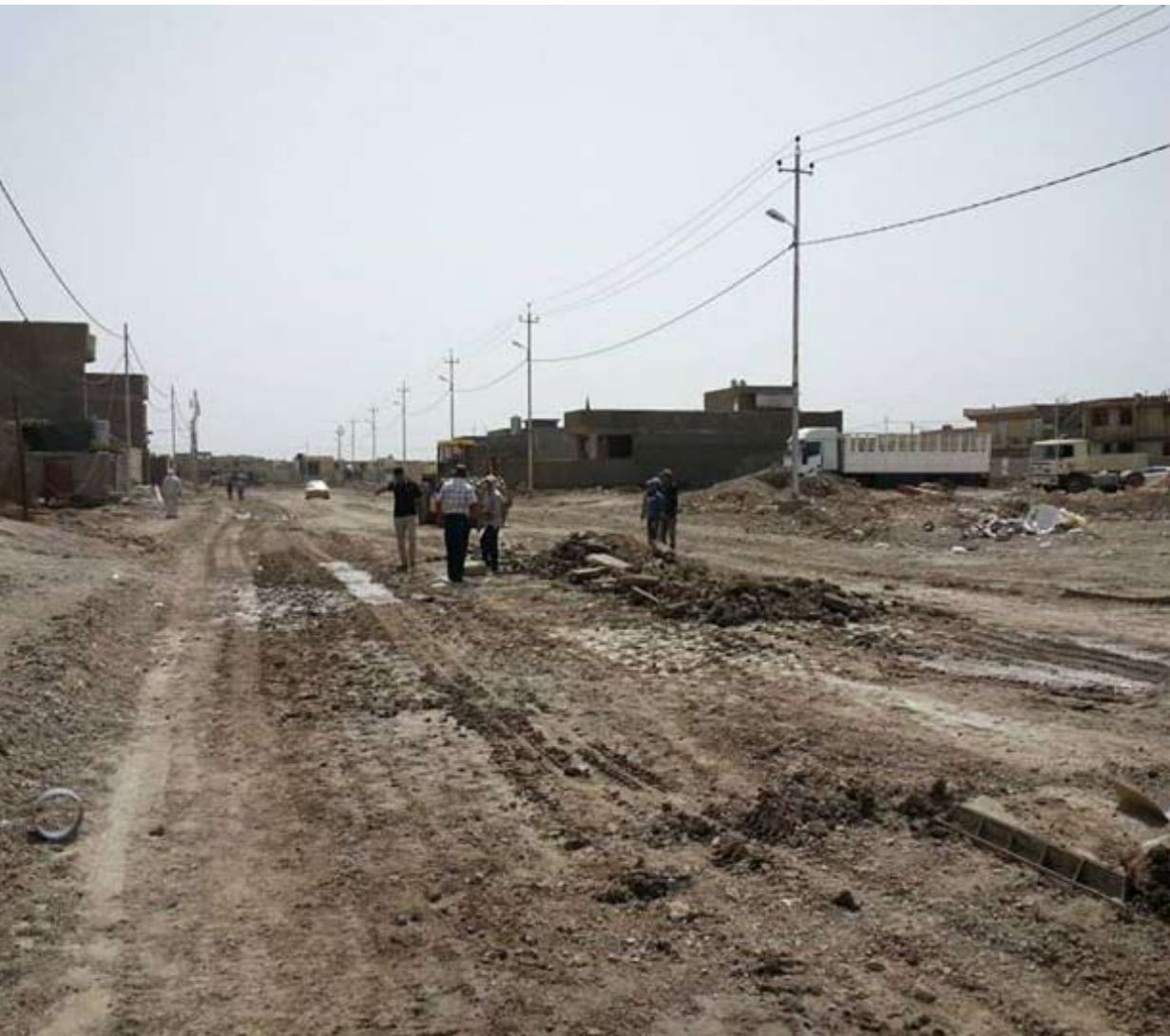
اعمال تبليط الشوارع الترابية في حي السلام بقضاء المحمودية: تراب وتراب... ولا أثر للتبليط ! «ارشيف»
